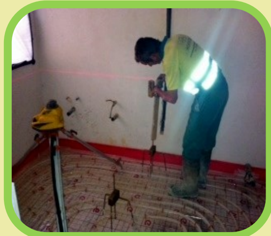
Colocación de arañas de nivel
