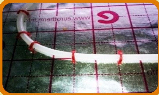
Anclado de tuberías
