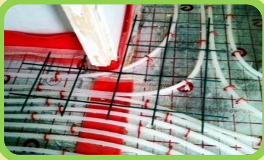
Refuerzo de esquinas
