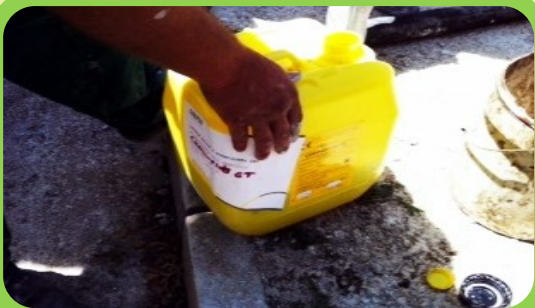
Re aditivación de mortero en obra
